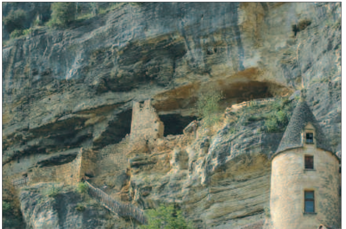
Le ventre sous la partie bâtie risque de se détacher
